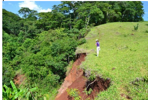
Figura 36. Reativação erosiva de um processo natural.
