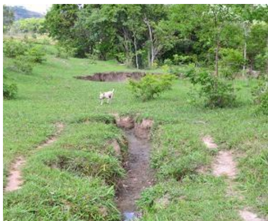
Figura 22. Sulcos próximo à cabeceira da erosão (Dez/2014)
