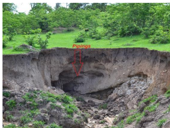
Figura 21. Presença de piping temporário na cabeceira da erosão.
