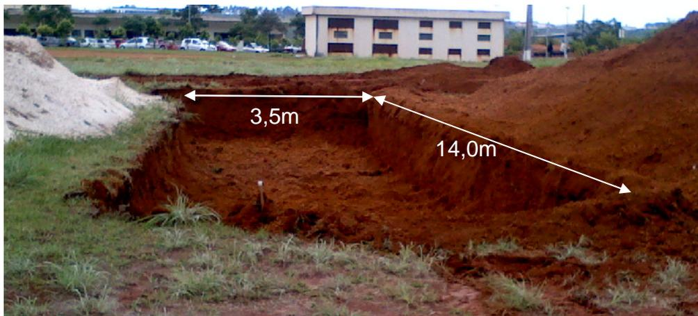
FIGURA 11: Imagem da vala aberta, onde foi construída a estrada protótipo.
