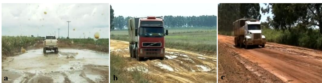
FIGURA 1. Problemas encontrados nas estradas brasileiras em 2013: a) Município de Bom Jesus-Piauí; b) Formoso do Rio Preto-Bahia; e c) Formoso do Rio Preto- Bahia (GLOBO RURAL, 2013).
