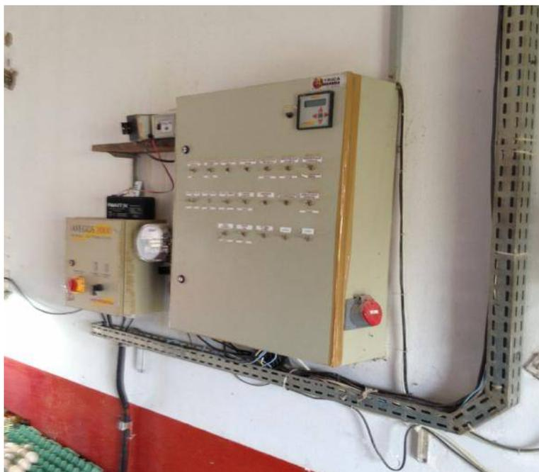
FIGURA 7. Equipamento utilizado para registrar o consumo de energia elétrica.
