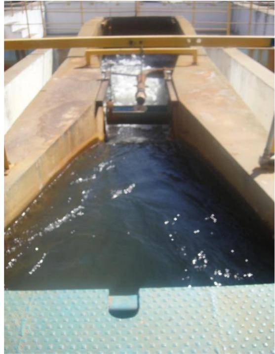
FIGURA 9 – Calha Parshall utilizada como misturador rápido, onde ocorre a adição do coagulante.
