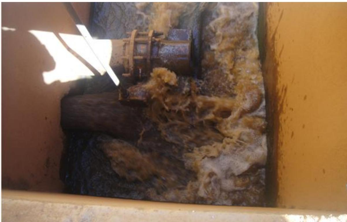
FIGURA 11 – Descarga do lodo de um decantador na canaleta lateral na ETA de Anápolis.
