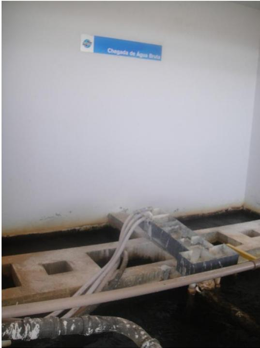
FIGURA 8 – Chegada da água bruta e dosagem da cal hidratada para correção do pH.
