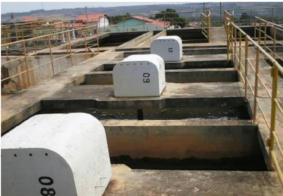
FIGURA 10 – Série de floculadores com impulsores rotativos de eixo vertical.
