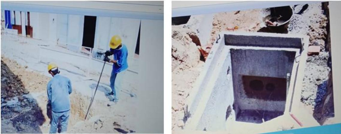
**Fonte:** Acervo NARQ (UEG, 2001). Abertura de valas pela empresa INELTO, para implantação da rede e abertura de solo para colocação das caixas de manutenção da rede elétrica.
