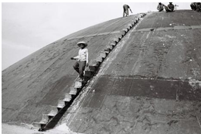
Fotografia 9 - Trabalhadores com suas vestes brancas e sem equipamentos de proteção na construção do congresso
