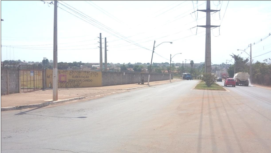
Figuras 13 e 14 - Avenida Progresso: Subestação de Senador Canedo e Acesso ao DASC, 2015
