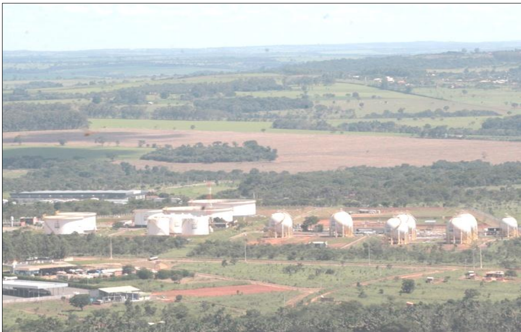
Figura 21 - Terminal de Combustíveis da Petrobrás em Senador Canedo (GO)
